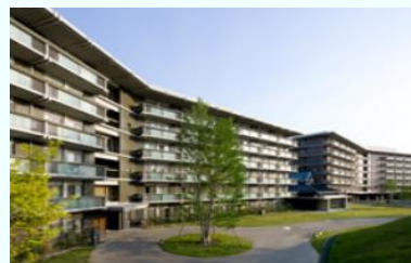
悲田院養護老人ホーム 外観
